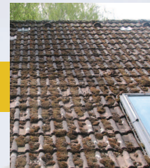
Dach vor und ...
