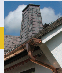
sanierter Dachrinnen aus Kupfer
