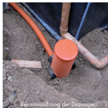
Revisionsöffnung der Drainage
